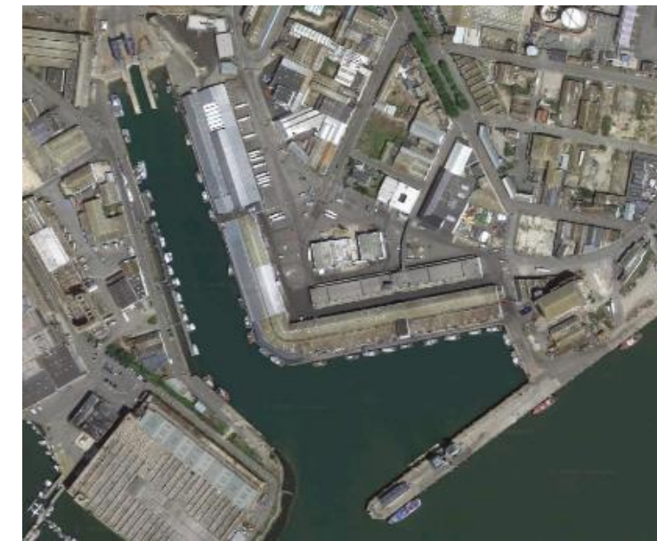
FIGURE 11 - VUE DU PORT DE LORIENT KEROMAN (SOURCE : GEOPORTAIL)
